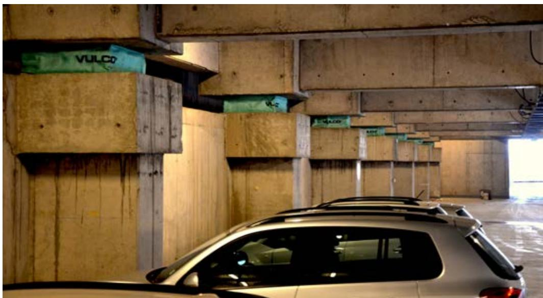
Sistema de aislamiento sísmico ubicado en el primer subterráneo del Edificio STEM.
